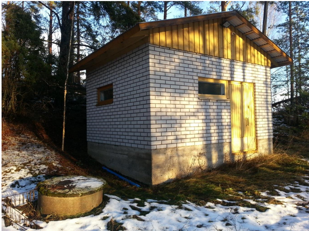
Kuva 2 Pauninmäen vedenottamo on ollut Myrskylän päävedenottamo, mutta nykyään se ei ole käytössä.
