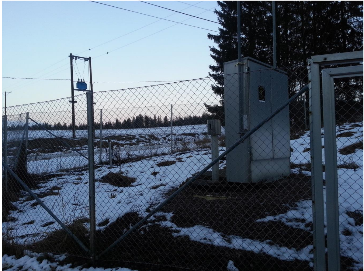
Kuva 4 Rauhalan vedenottamo on aidattu. Vedenottamon takana sijaitseva muuntamo jäähdytetään biohajoavalla öljyllä, joka ei aiheuta pohjaveden pilaantumiseriskiä.
